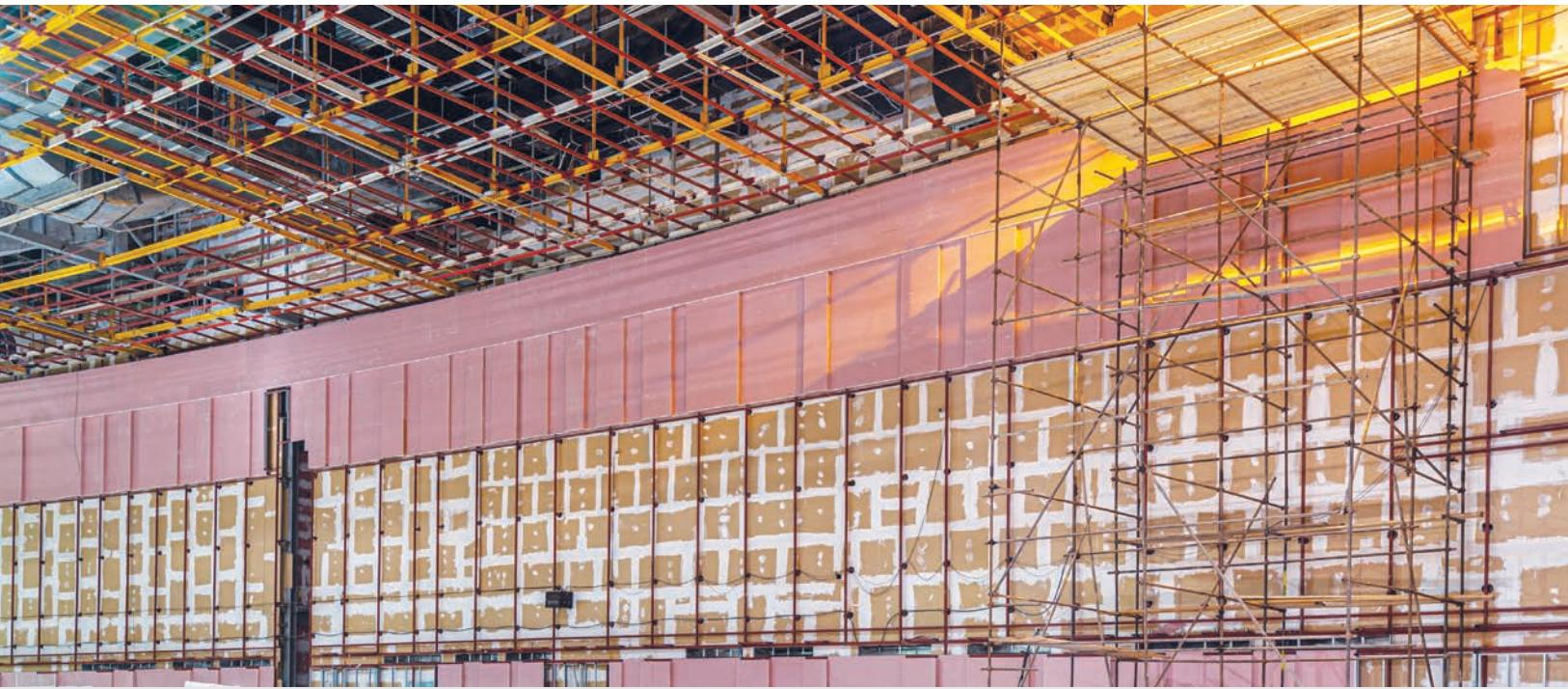
تا قبل از جنگ جهانی دوم، اندود گچی رایج‌ترین مصالح برای پوشش داخلی منازل و بسیاری از ساختمان‌ها در اروپا به شمار می‌رفت. در آن زمان واژه خشک برای مصالح پوششی دیوار که نیاز به اندود گچ نداشت، به کار می‌رفت. در سال‌های پس از جنگ جهانی دوم استفاده از سیستم‌های دیوار خشک به علت این که مشکلات سیستم اندود گچی (از قبیل نیاز به نیروی کار متخصص، وزن بیشتر، نفوذ رطوبت به ساختار زیرین، سرعت پایین و صرف زمان برای خشک شدن قبل از عملیات رنگ‌کاری) را برطرف می‌نمود به سرعت گسترش یافت.
