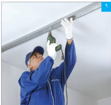
نصب رانر سقف (سوراخ کردن رانر و سقف)
