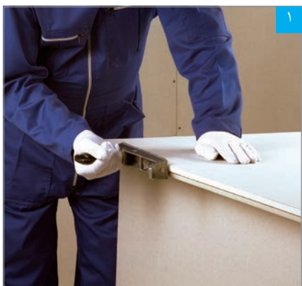
پرداخت لبه برش خورده با رنده
