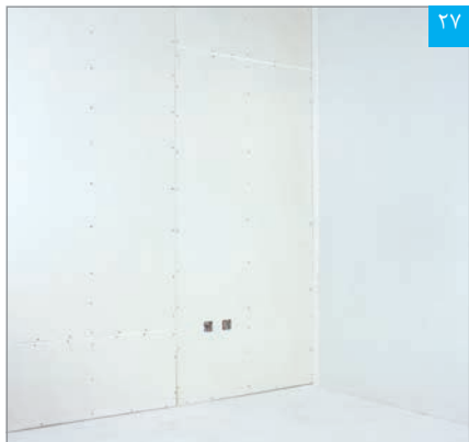
دیوار تکمیل شده (خروجی‌های تاسیساتی به وسیله گردبهر یا اره چاقویی و سوهان ایجاد می‌شوند)
