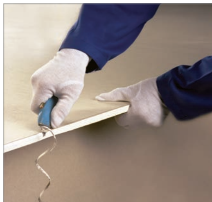
اجرای پخ با تیغ برش
