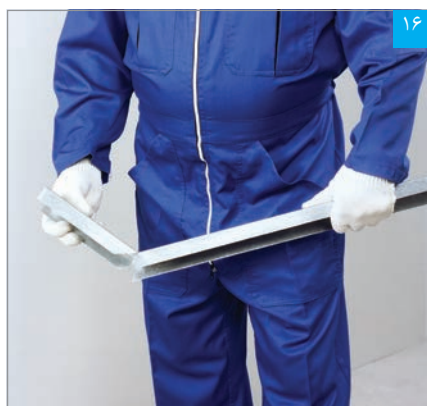
۱۶ خم کردن انتهای رانر نعل درگاه
