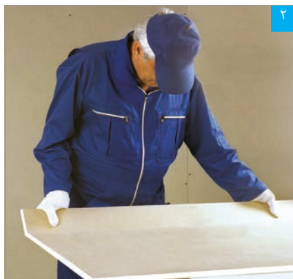
شکستن پنل در محل برش
