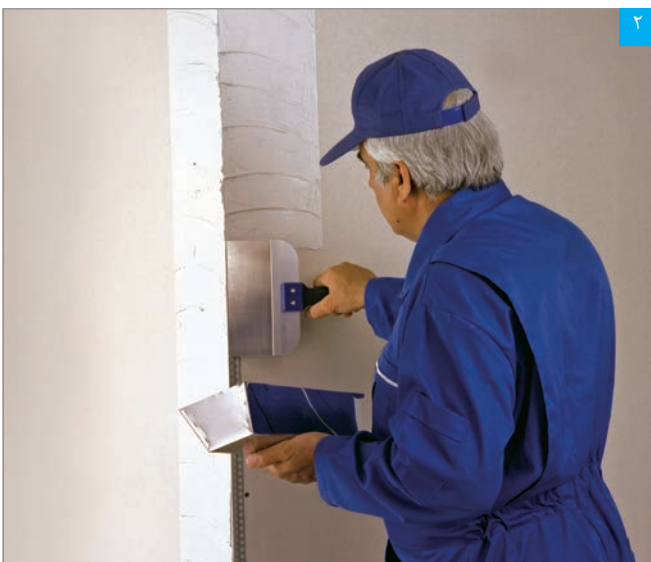
اجرای بتونه روی سازه محافظ گوشه
