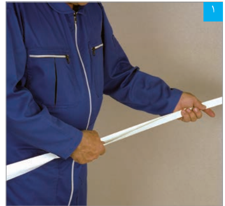
خم کردن نوار درزگیر با دست
