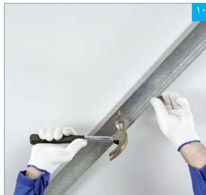
اتصال رانر به سقف با رول پلاگ
