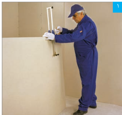
برش پنل با دستگاه برش طولی
