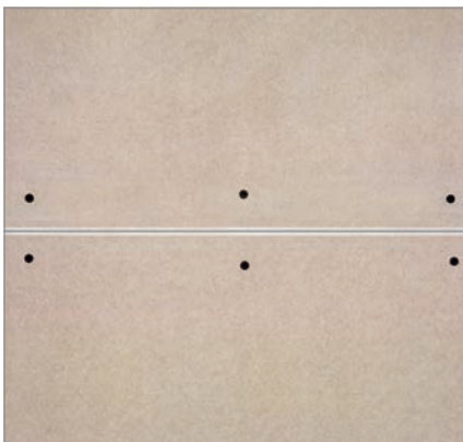
تصویر اجرا شده یک درز با دولبه پخ خورده
