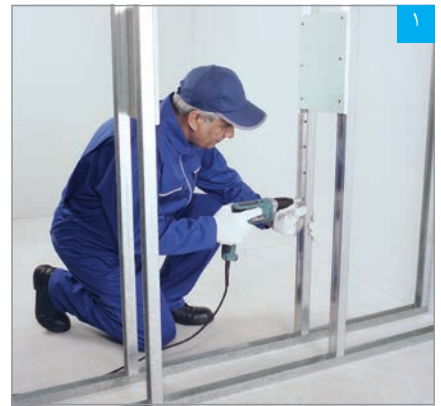
اتصال قطعات نبشی L25 به استادهای مجاور
