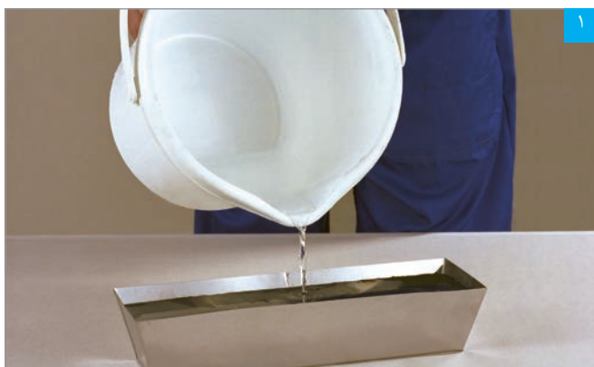
ریختن آب در ظرف تهیه بتونه
