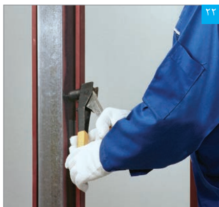
۲۲ رانر تقویتی توسط پرچ به استاد متصل می شود
