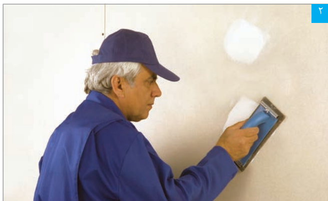
پرداخت سطح بتونه خشک
