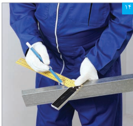
۱۴ علامت گذاری انتهای رانر نعل درگاه به صورت فارسی بر (به اندازه ۲۰ سانتی متر)
