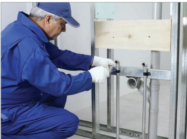
اتصال لوله‌های تاسیساتی به سازه پشتیبان SP60
