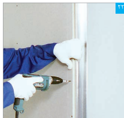
۲۲ پنل باید در جهتی نصب شود که لبه آزاد آن به سمت دهانه باز استاد قرار گیرد
