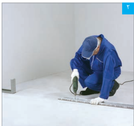
نصب رانر کف
