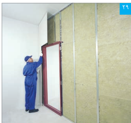
اجرای پنل سوم دور چهارچوب پس از عایق‌گذاری (پنل‌ها نسبت به سمت اول بصورت حصیرچین اجرا می‌شوند)
