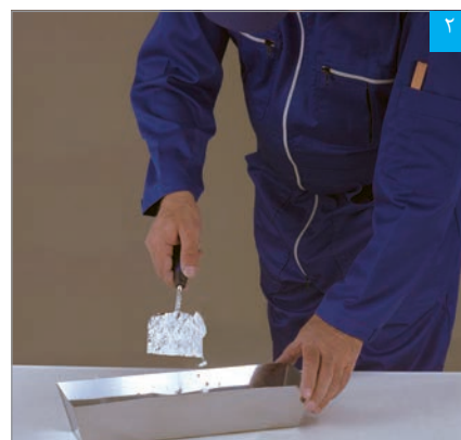
ریختن پودر بتونه در آب
