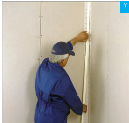
قرار دادن نوار درزگیر بر روی بتونه
