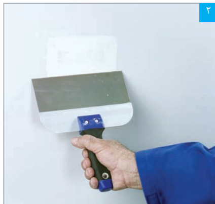
اجرای بتونه بر روی وصله ترمیمی
