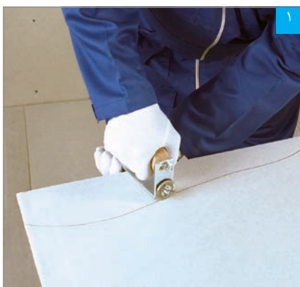
اجرای برش موج‌دار با دستگاه برش قرقره‌ای
