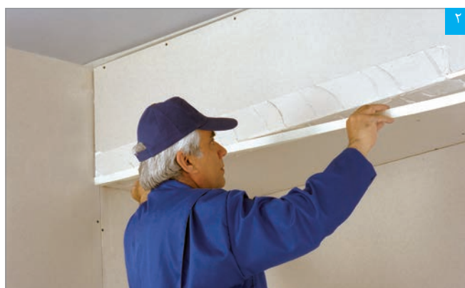
قرار دادن نوار درزگیر بر روی بتونه
