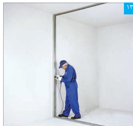
۱۳ نصب استاد بر روی ساختار جانبی (سوراخ کردن استاد و دیوار)
