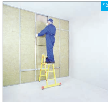
اجرای عایق پشم‌معدنی در فواصل بین استادها (توجه شود که تاسیسات در مرحله قبل اجرا شده است)
