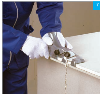
اجرای پخ با پخ زن
