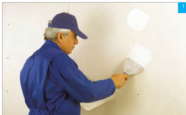
اجرای بتونه در محل پیچ‌ها
