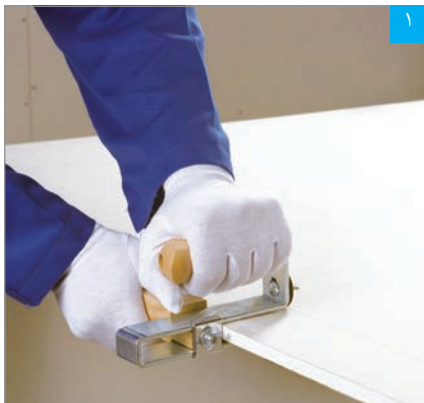
برش پنل با دستگاه برش قرقره‌ای
