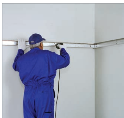
نصب سازه تراز باربر
