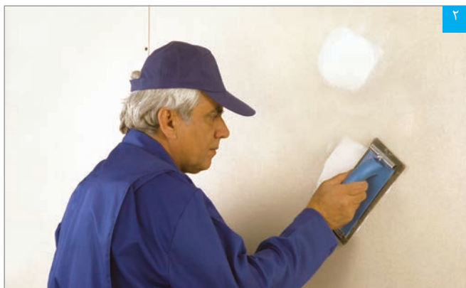
پرداخت سطح بتونه خشک
