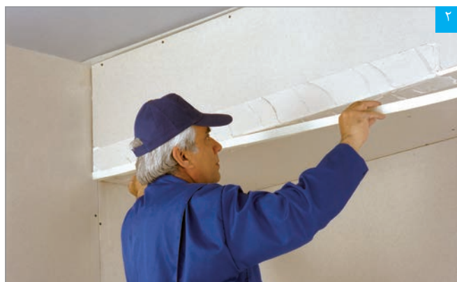
قرار دادن نوار درزگیر بر روی بتونه
