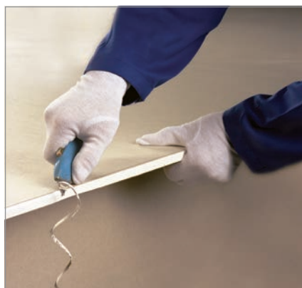
اجرای پخ با تیغ برش
