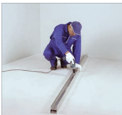
اجرای سازه سقفی دوتایی
