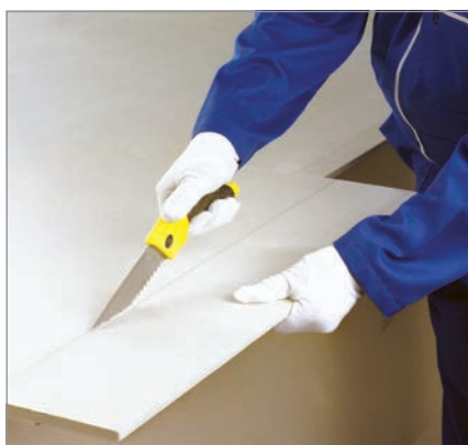
برش پنل با اره دستی
