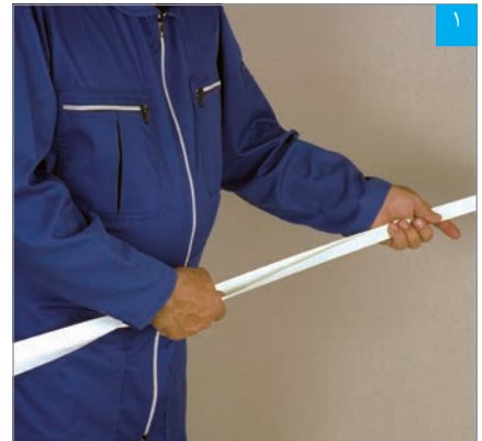
خم کردن نوار درزگیر با دست
