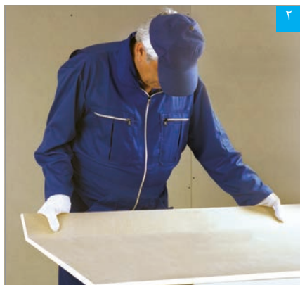
شکستن پنل در محل برش
