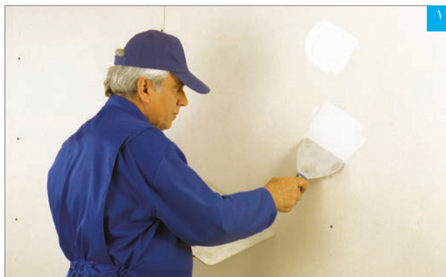
اجرای بتونه در محل پیچ‌ها
