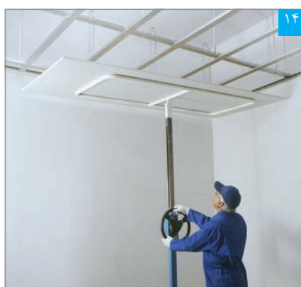
۱۴ استقرار پنل با استفاده از بالابر
