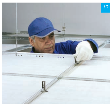
قرار دادن گیره‌های مخصوص نگهدارنده تایل
