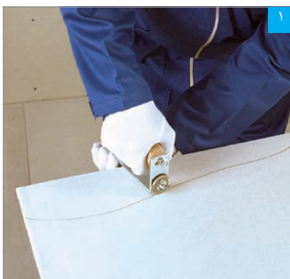
اجرای برش موج‌دار با دستگاه برش قرقراهی
