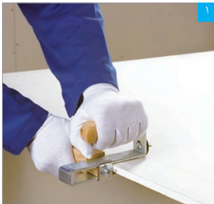
برش پنل با دستگاه برش قرقراهی
