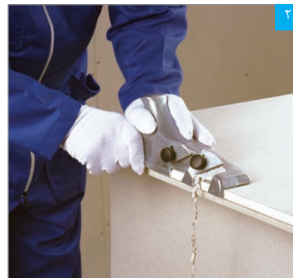
اجرای پخ با پخ زن
