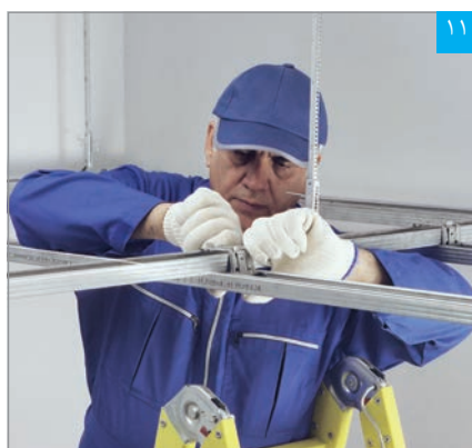
۱۱ اتصال سازه پنل‌خور به سازه باربر توسط قطعه اتصال کامل
