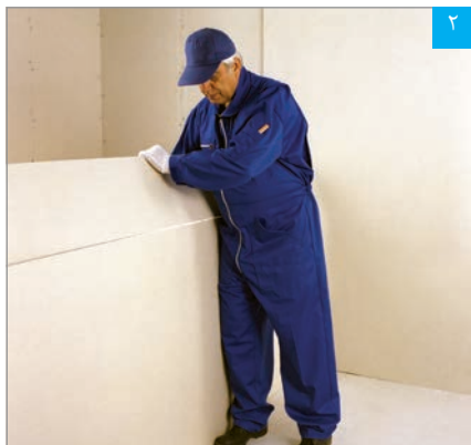
شکستن پنل در محل برش
